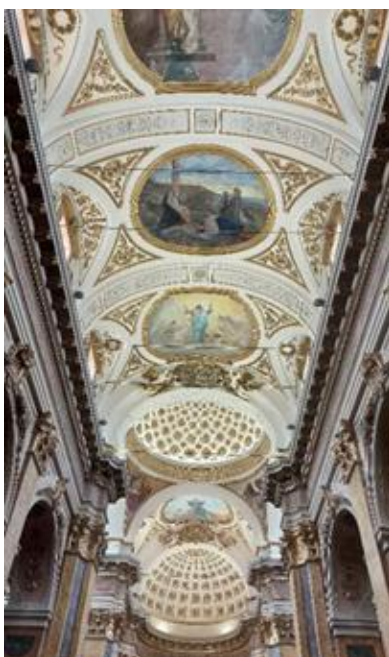
La Volta del Santuario, restaurata, ripulita e arricchita con nuova illuminazione.
